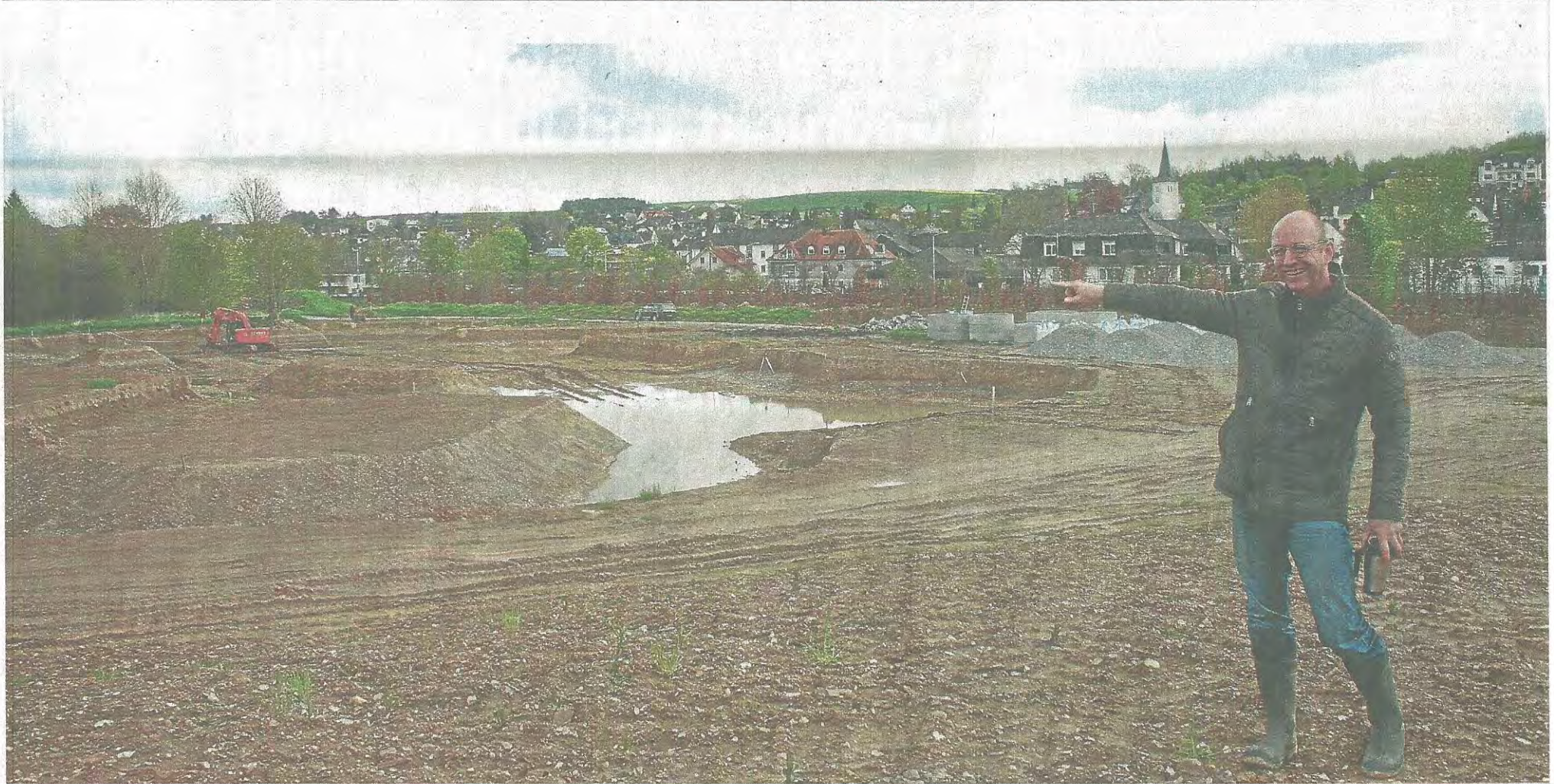
Da geht es weiter: Froh, dass der immer noch feuchte Untergrund inzwischen ein Arbeiten mit schweren Maschinen wieder zulässt, zeigt Christian Droop über den Teich hinweg in die Ecke des Botanischen Gartens, in der später ein Rhododendronhain blühen soll.
